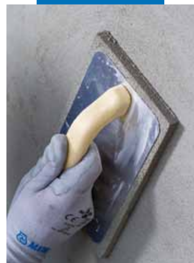
Frattazzatura di Planitop Rasa & Ripara R4
