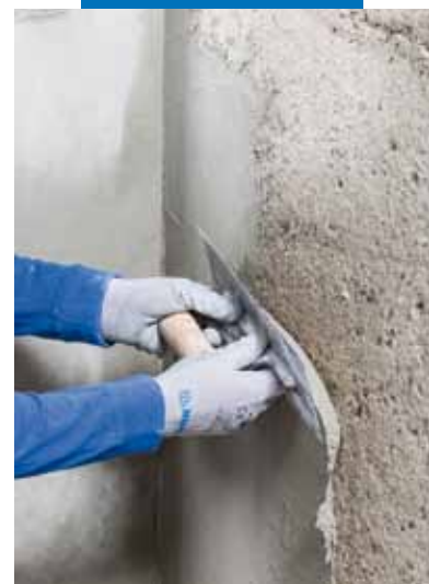
Applicazione a spatola di Planitop Rasa & Ripara R4
